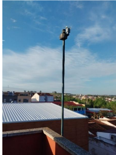
Figura 1. Instalación de los módulos exteriores de la estación meteorológica
